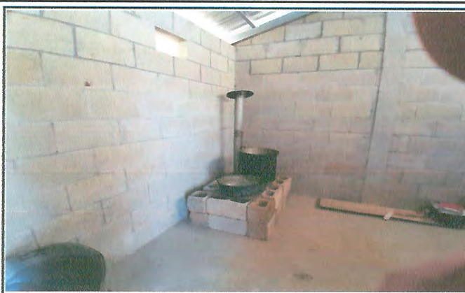
Foto 2: Sustrucción de Estufa rural, plancha y su chimenea
