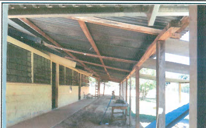
Foto 2: Cambio de estructura de madera a metal
