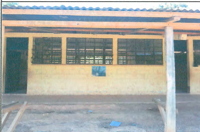
Foto 4: Patio frontal mejorara con losa de piso
