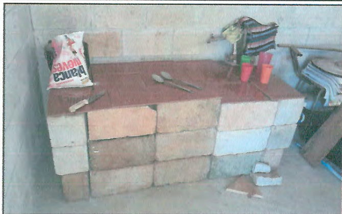
Foto 1: Sustrucción de lavatrastes, grifos y azulejos
