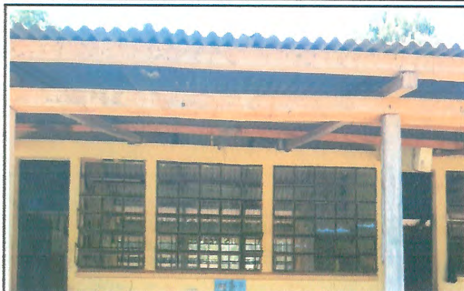
Foto 1: Mejoramiento de estructura de techo
