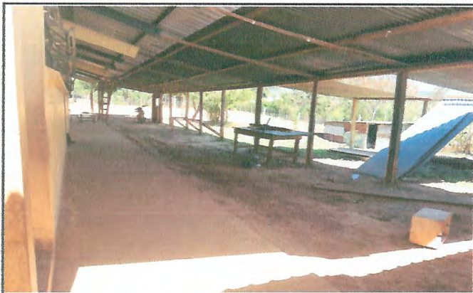
Foto 1: Mejoramiento de patio (aplanar)
