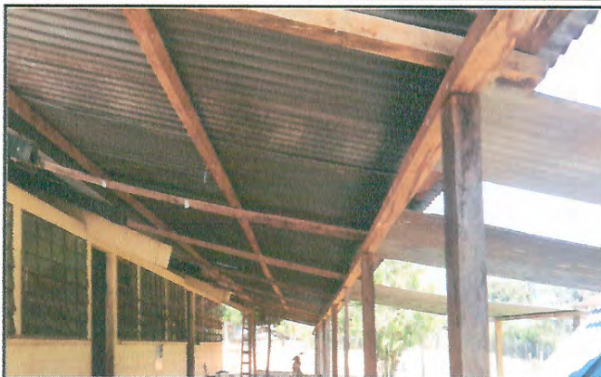
Foto 2: Cambio cubierta de lamina patio
