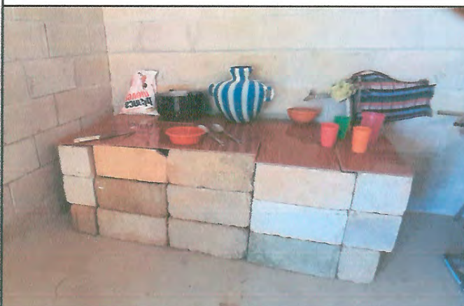
Foto 4: Sustrucción de Pila o deposito de agua
