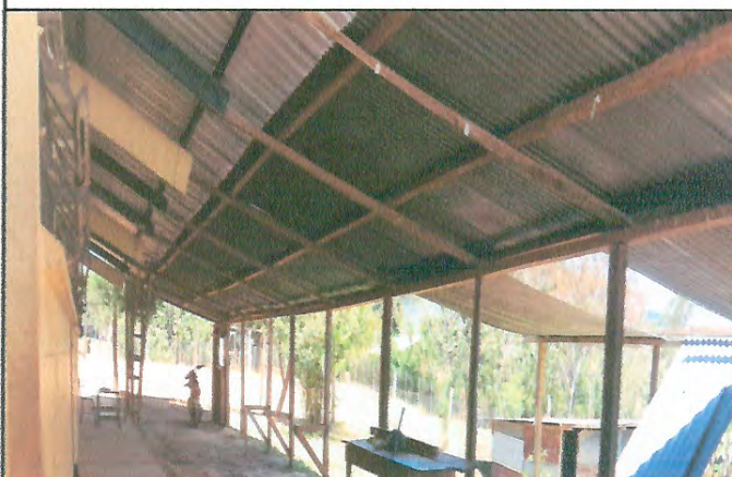
Foto 4: Mejoramiento estructura de techo del patio
