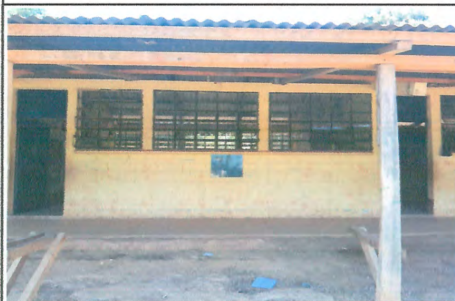
Foto 4: Mejoramiento cubierta de lamina patio
