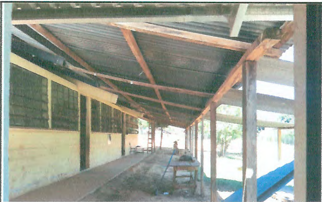
Foto 1: Cambio cubierta de lamina
