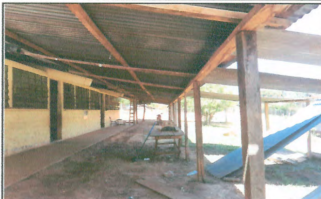
Foto 2: Aplicar losa de piso al patio
