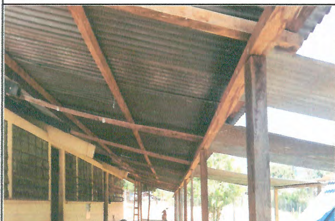
Foto 3: Mejoramiento estructura de techo del patio
